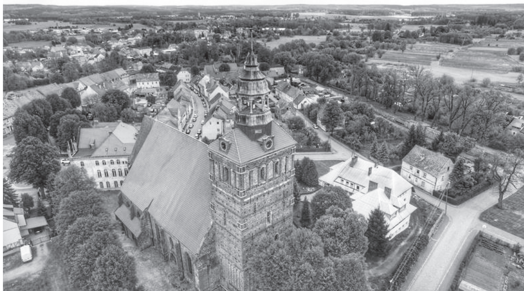
Rycina 2. Fragment panoramy Ośna Lubuskiego z widoczną z daleka wieżą i dzwonnica kościoła farnego Na pierwszym planie bryła wielokrotnie remontowanego i rozbudowywanego gotyckiego kościoła pod wezwaniem Św. Jakuba Apostoła, z przełomu XIII i XIV wieku.
